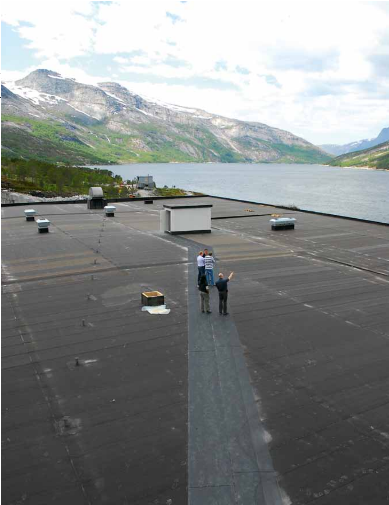
Digert: Settefiskanlegget i Mørsvika har store dimensjoner. Bildet er tatt fra taket av bygningen på til sammen 7500 kvm over tre etasjer.
